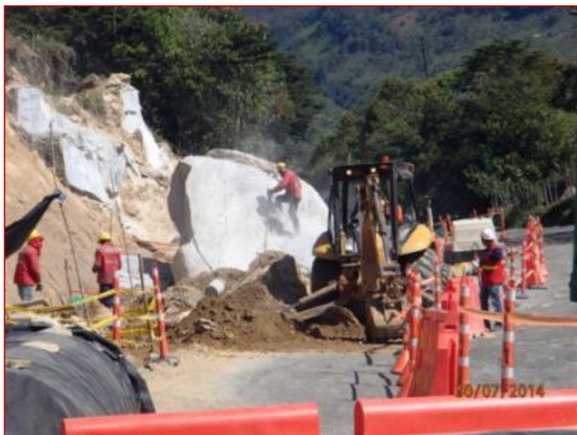
K 19+509. Demolición de roca
