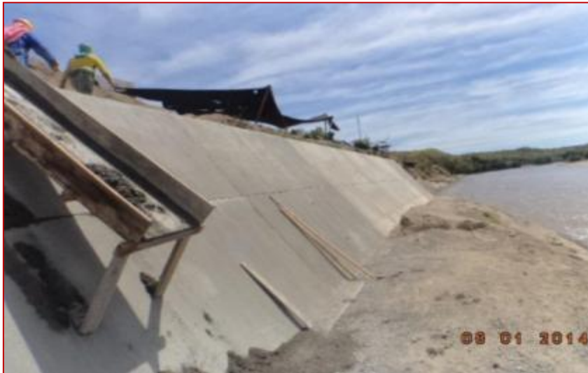
Terminado de placas de concreto para Pantalla del K42+950 al K43+080
