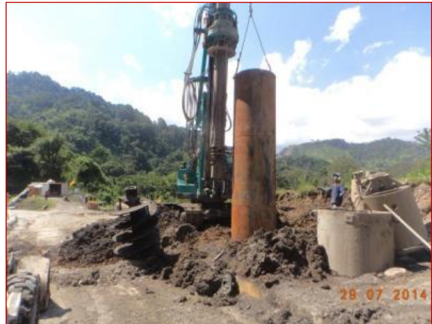
Sitio Crítico: Estabilización Intersección Chinchiná - Barricada de pilotes: Excavación de Pilote
