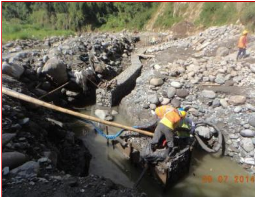
Sitio Critico: Manejo de cuenca rio Chinchiná - Puente Cenicafé: Excavación y Construcción Gaviones Espolón
