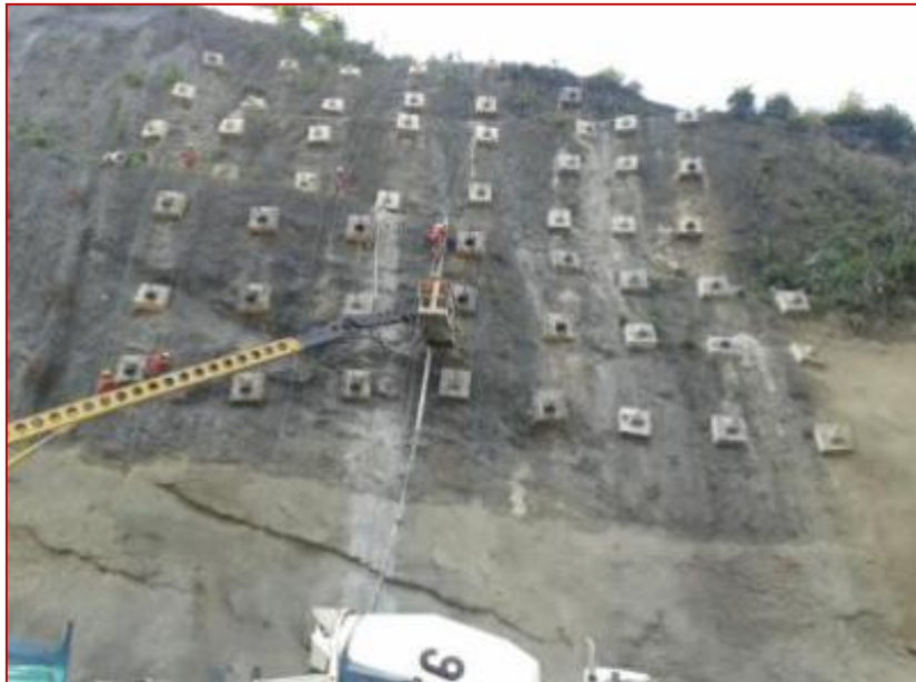
Construcción de dados en el K67+300
