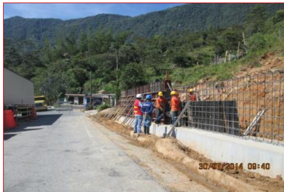
K19+676. Nivelado y apuntalado de formaleta
