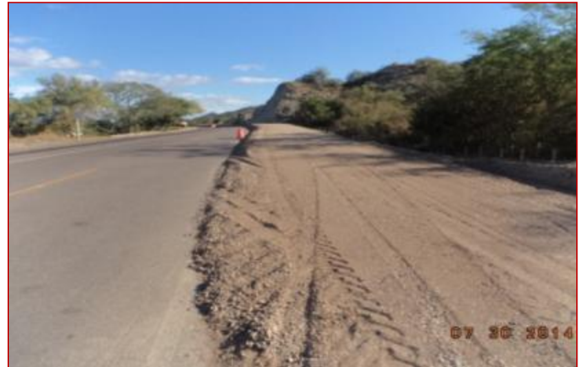
Extendida de base granular de vía nueva K43+208 al K43+360
