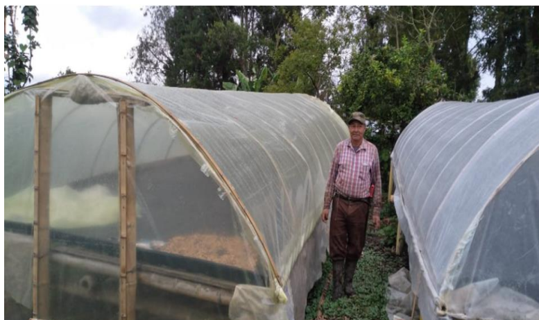
Instalación de plástico para secadero parabólico, municipio de Caldon
