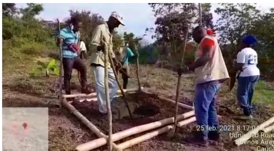
Jornada de Minga o Mano cambiada, corregimiento de La Balsa, municipio de Buenos Aires. Construcción Cama Biológica. Finca María Imelda Solarte
