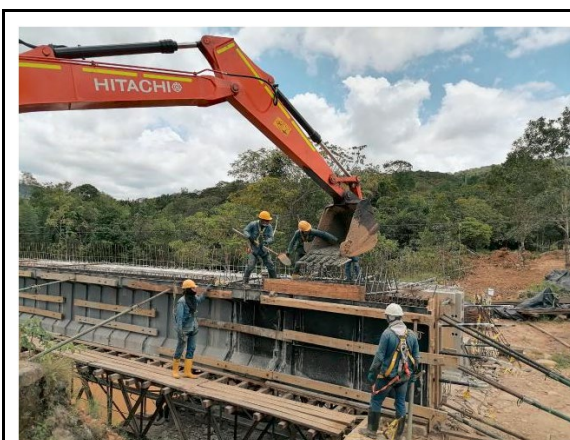
Fundida de viga 3, 27/08/2021
