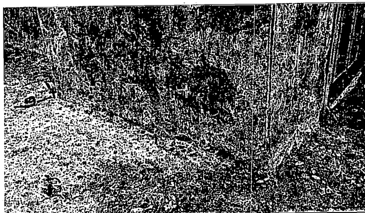
Figura 28. Segregación en la base del muro con afectación biológica.
