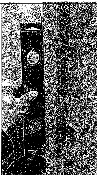
Figura 45. Muro desplomado.
