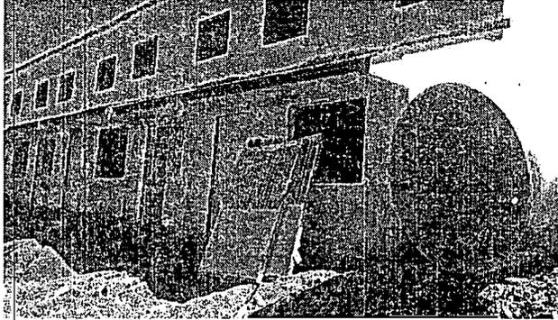
**Foto 7.** No se están acopiando de manera correcta las puertas y elementos metálicos, lo que genera su deterioro y posible no conformidad al momento de su instalación.
