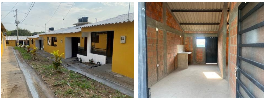
Foto 11. Viviendas entregadas en el municipio de Prado, departamento del Tolima
