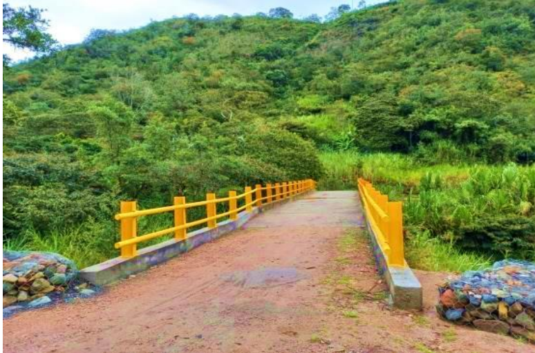
Foto 2. Construcción Puente Vehicular en el municipio de San Joaquín
