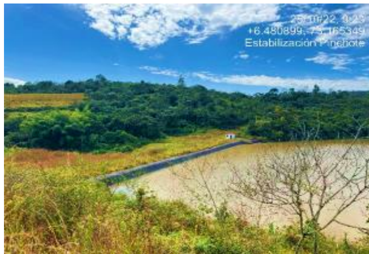
Foto 3. Estabilización Represa La Laja en el Municipio de Pinchote
