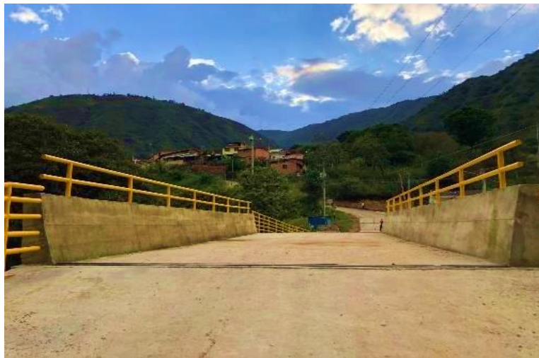
Foto 1. Puente Hospital en el municipio de Onzaga
