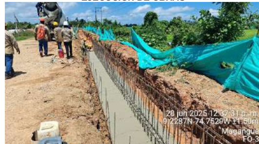
Imagen 6;Construcción de base del muro en concreto de 4.000 PSI. FO-3 Municipio de Magangué
