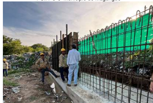
Imagen 7; construcción de Muro en concreto , Frente de Obra No 6 Yatí Armado de acero
