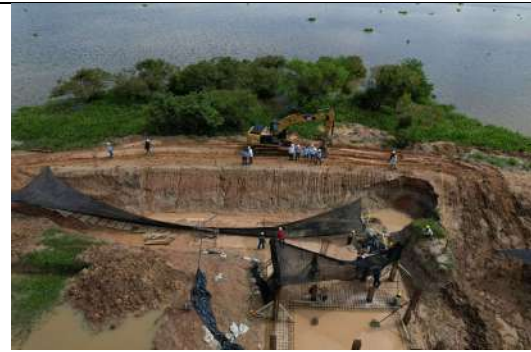
Imagen; 4 Excavación para Estación de Bombeo Pondaje No. 4 -frente 5- Municipio de San Marcos
