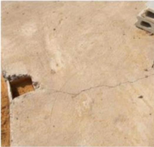
*Ilustración 26 Losa de piso con fisuras- Juttial*
