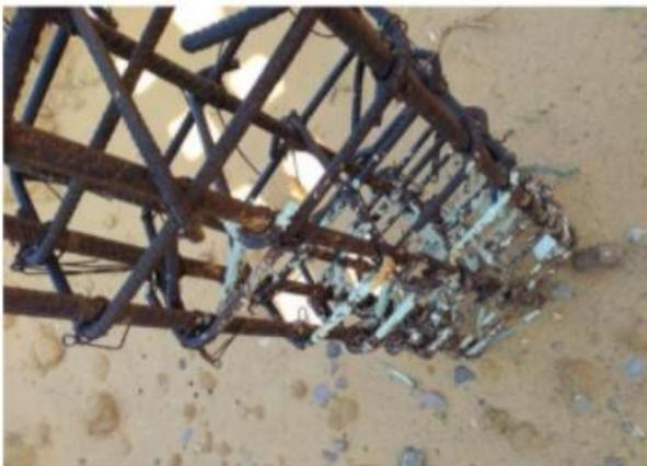
*Ilustración 28 Platinas Oxidadas Juttial*
