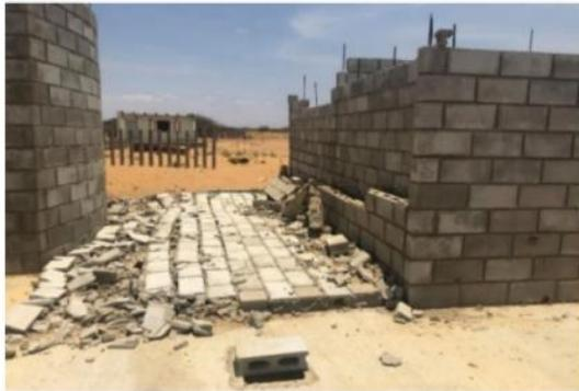
*Ilustración 30 Muro caído - Juttial*
