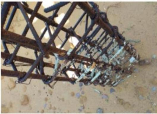
*Ilustración 28 Platinas Oxidadas Juttial*
