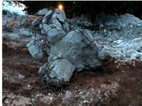
Fotografía 41. Demolición de zapata
