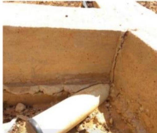
*Ilustración 70 Fisura conexión de vigas- Yotojorotshi*
