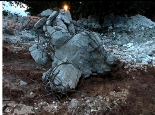
Fotografía 41. Demolición de zapata
