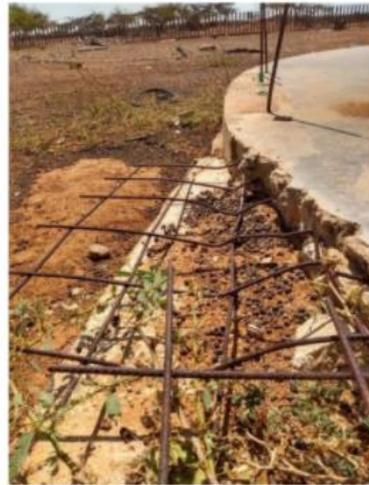
*Ilustración 75 Malla electrosoldada oxidada- Yotojorotshi*
