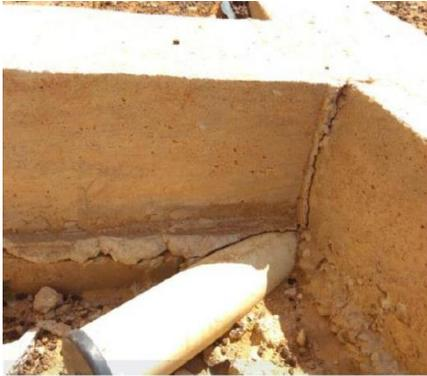
Fotografía 70. Fisura conexión de vigas - Yotojorotshi
