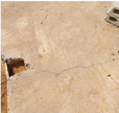
Fotografía 26. Losa de piso con fisuras - Juttial
