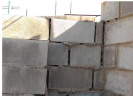
*Ilustración 33 Falta de mortero de pega*
