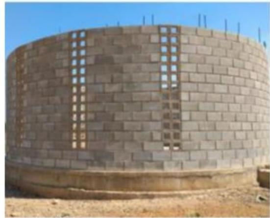
*Ilustración 73 Refuerzo de dovelas expuesto- Yotojorotshi*
