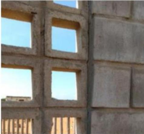
Ilustración 39 Fisuras en muro
