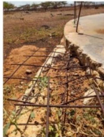
*Ilustración 75 Malla electrosoldada oxidada- Yotojorotshi*
