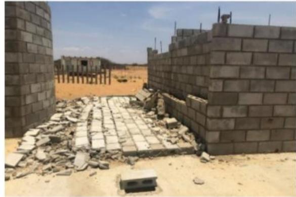
*Ilustración 30 Muro caído - Juttial*
