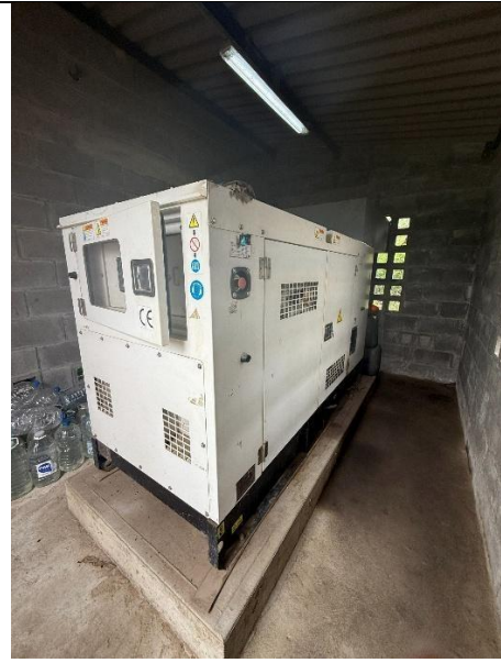
PTARD del Proyecto. Hito 6. Obras Complementarias
