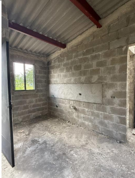
Vista interior de la vivienda- Cocina
