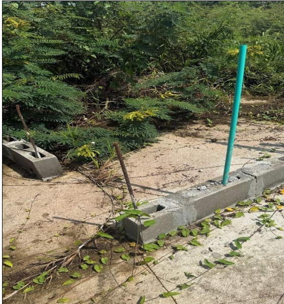
Bloque 14 estado de la vivienda
