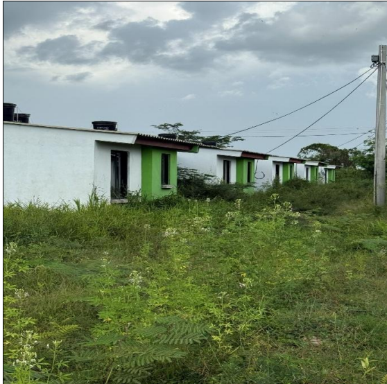
Viviendas finalizadas Bloque 2 al 6
