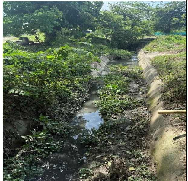
Estado del Canal Interno. Hito 7. Obras de Mitigación
