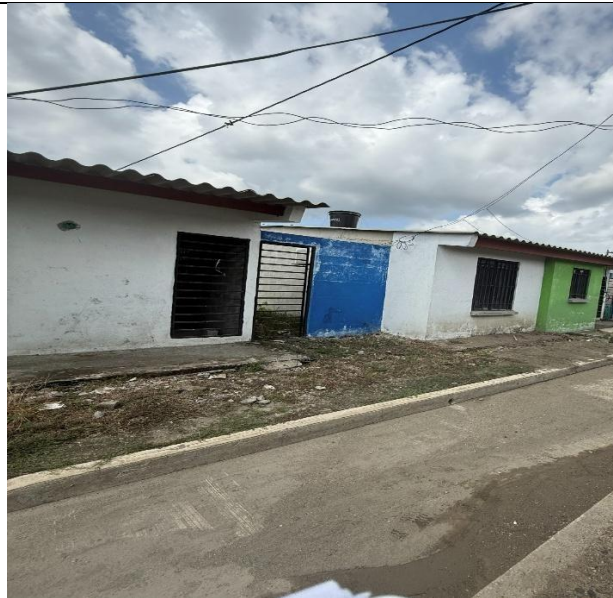
Viviendas finalizadas Bloque 2 al 6
