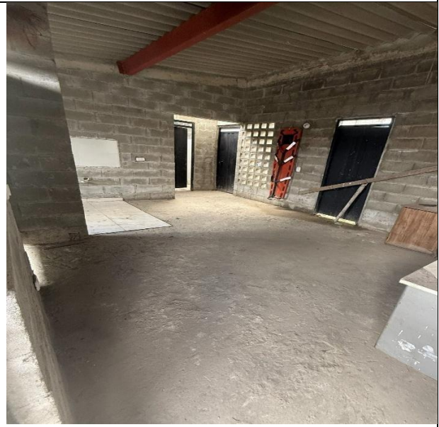
Estado interior sala - comedor de la vivienda finalizada
