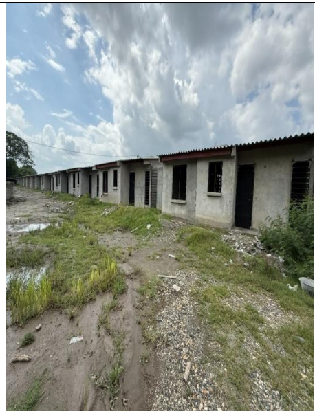
Vista frontal del Bloque 1, sin instalar las ventanas
