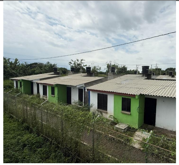
Viviendas finalizadas Bloque 2 al 6
