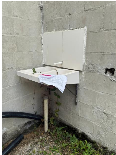
Estado interior de la vivienda finalizada
