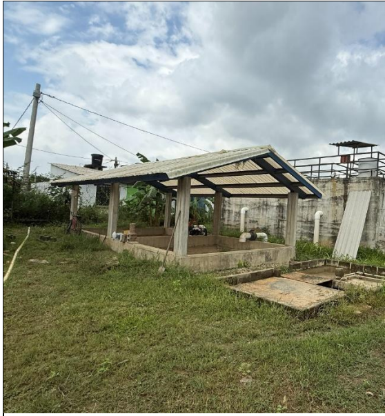
PTARD del Proyecto. Hito 6. Obras Complementarias
