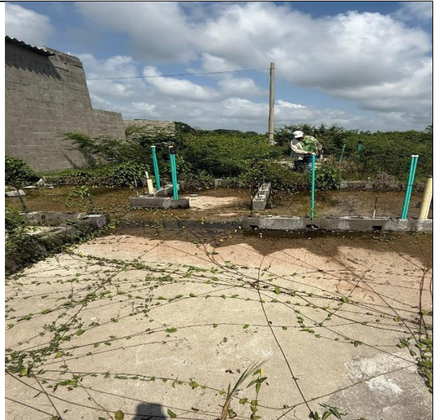
Bloque 14 estado de la vivienda
