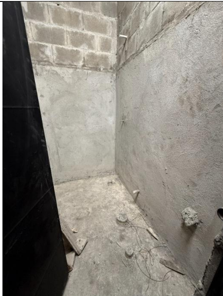
Vista interior de la vivienda- Baño
