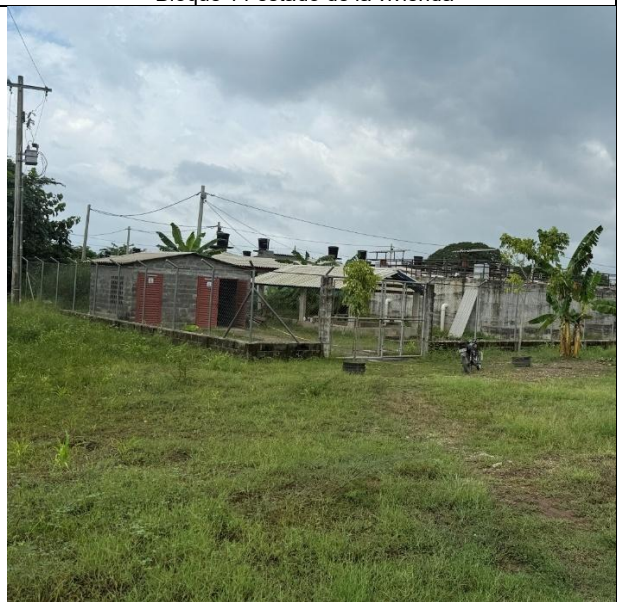
PTARD del Proyecto. Hito 6. Obras Complementarias
