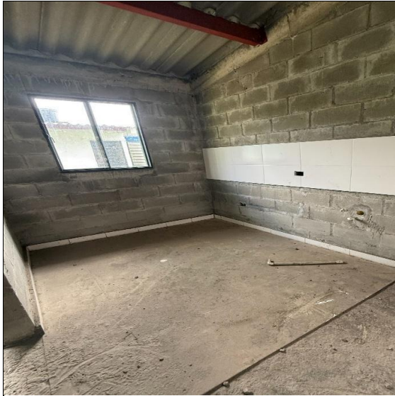
Estado interior de la cocina
