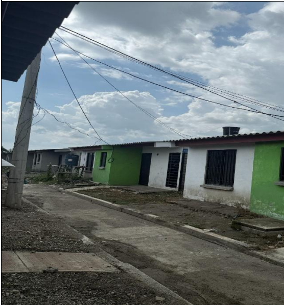
Viviendas finalizadas Bloque 2 al 6
