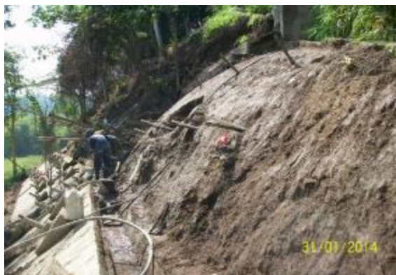
Obras externas de estabilización – canal
