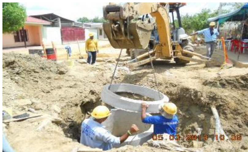
Instalación de tubería de Alcantarillado
