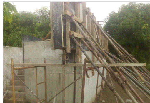
Formaleta para pozo de bombeo de tanque semienterrado
