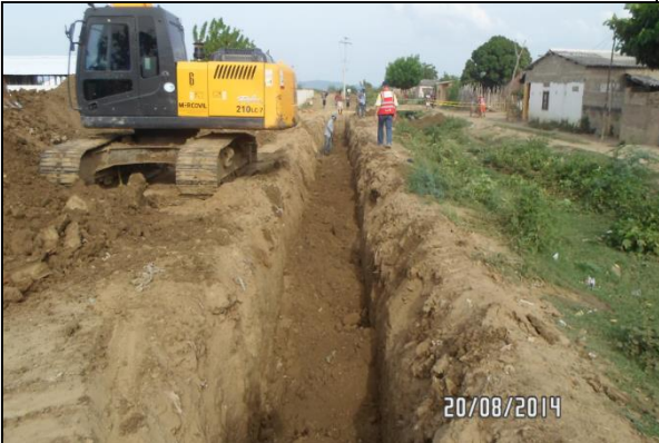
Instalación y cimentación red alcantarillado de 24"
