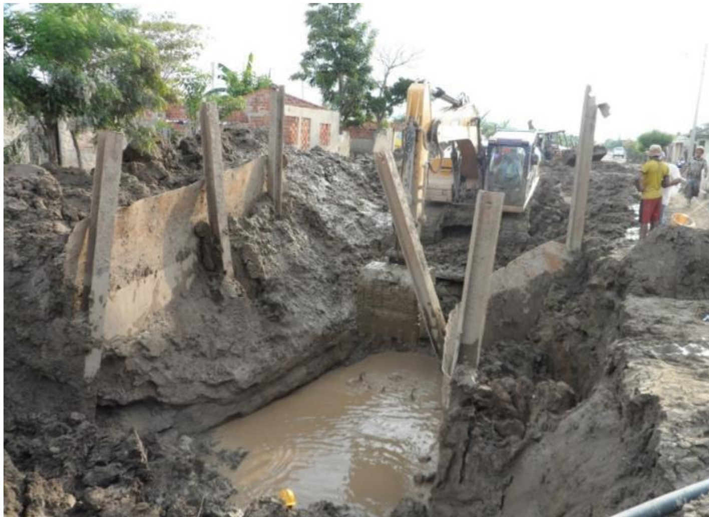
Instalación Colector Campo de la Cruz
