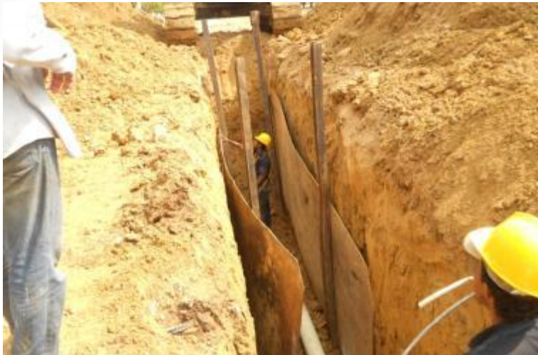
Instalación redes de alcantarillado (con entibado)
