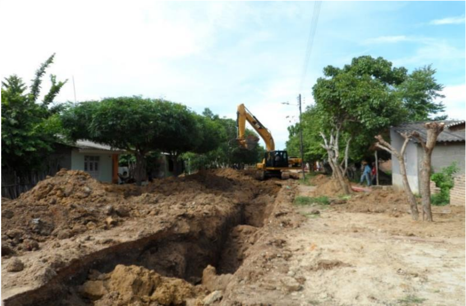
Excavación para instalación colector
