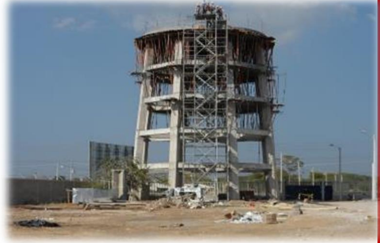
Fundida ultimo nivel de la base del tanque elevado - Manatí
