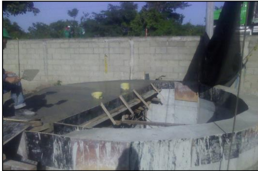
Vaciado de losa superior de pozo de lodos
