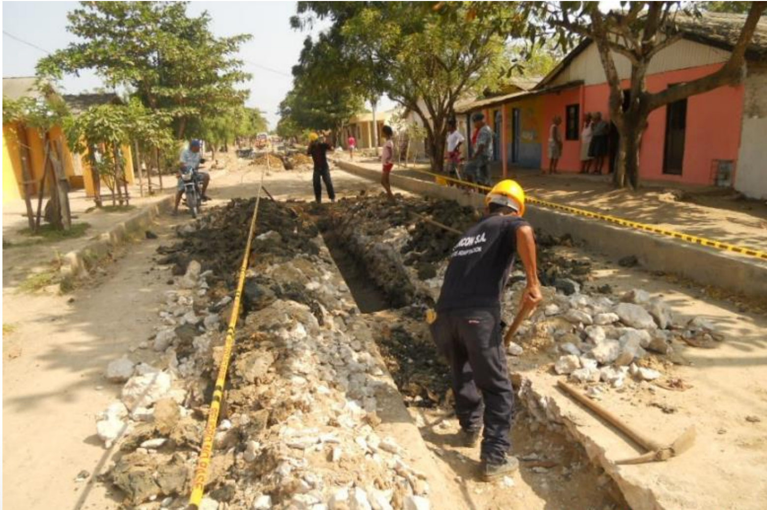
Instalación de tubería de Alcantarillado
