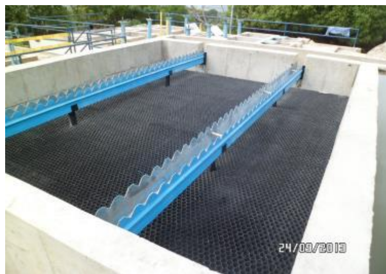
Redes y Sedimentador PTAP – Municipio de Luruaco
