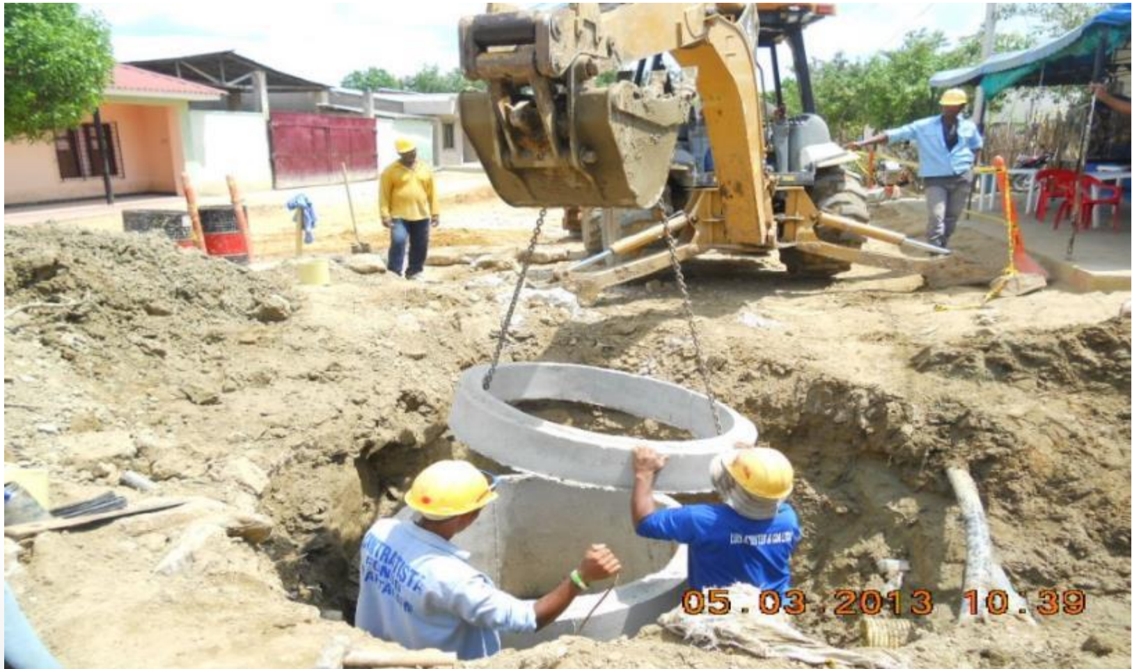
Instalación pozos de inspección prefabricados
