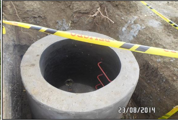
Construcción de pozos de inspección
