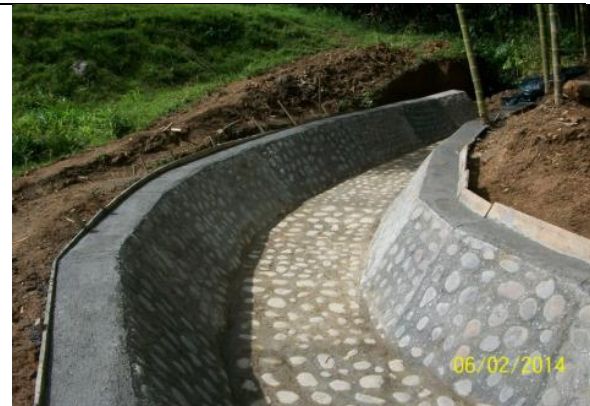
Manejo de aguas superficiales - canal
