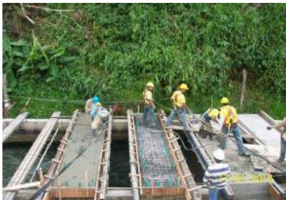
Intervención canal abierto, aducción – nuevo Libaré
