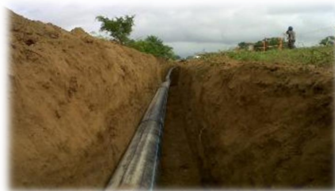
Instalación tubería de aducción - Repelón
