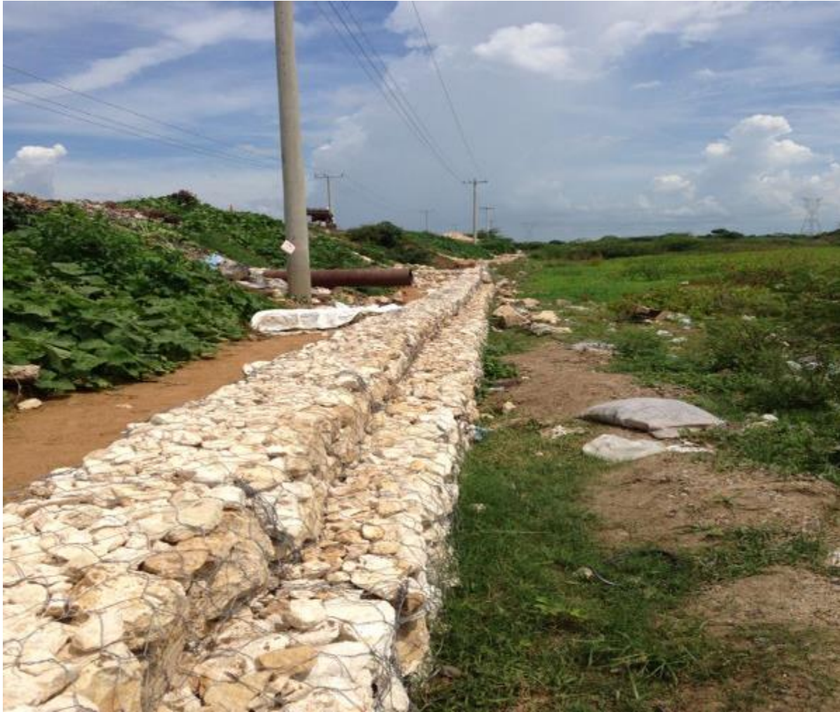
Protección en Gavión de la Aducción Repelón
