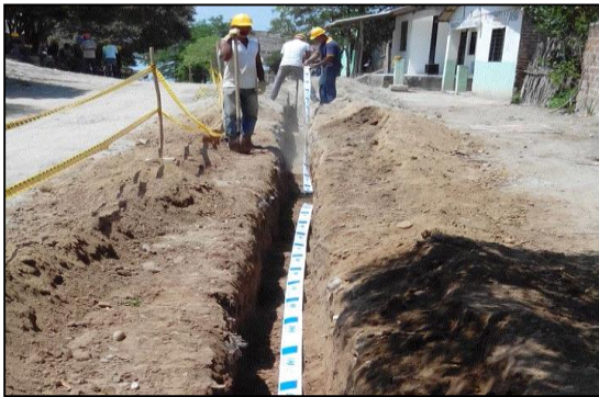
Instalación de redes de distribución
