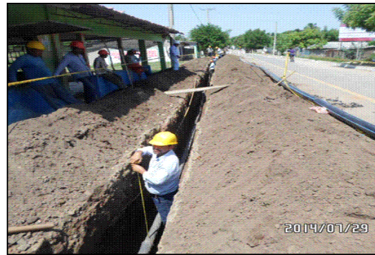
Excavación e instalación de redes de distribución
