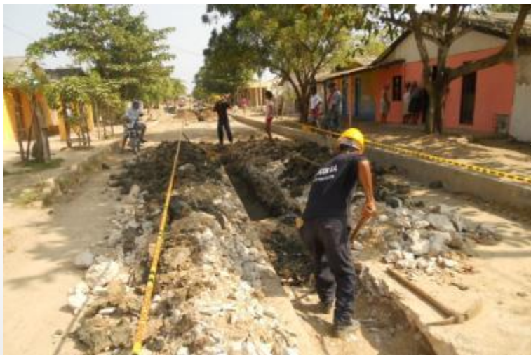
Instalación redes de alcantarillado (con entibado)
