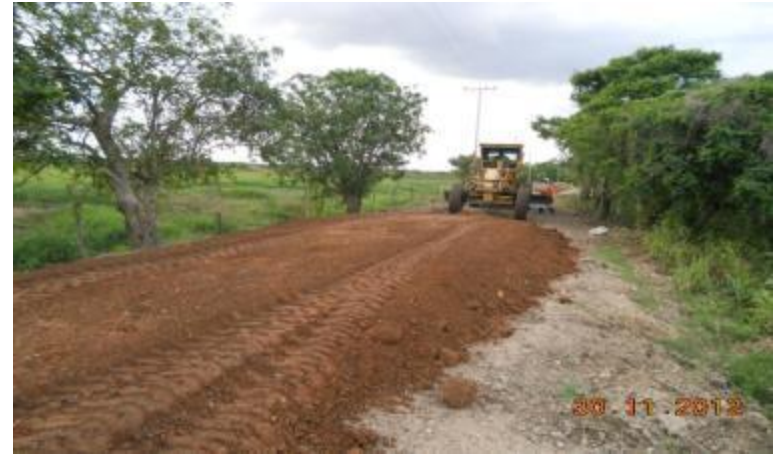
Conformación terraplén
