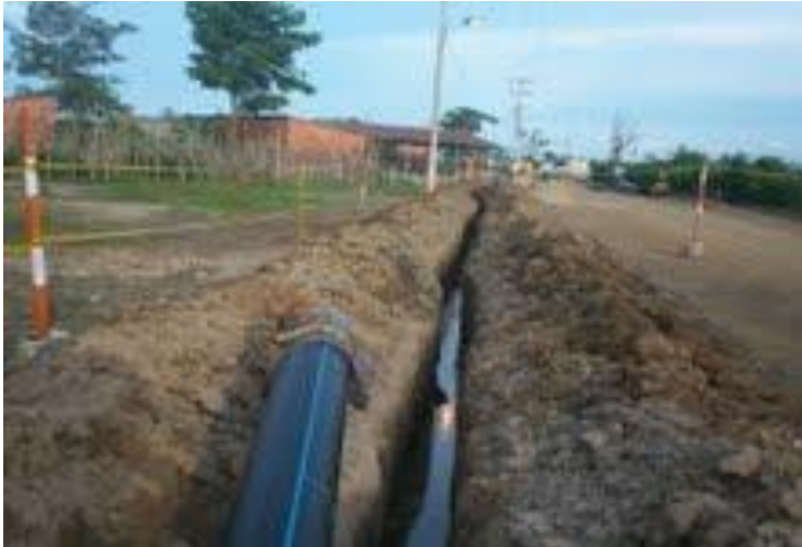
Instalación tubería de impulsión
