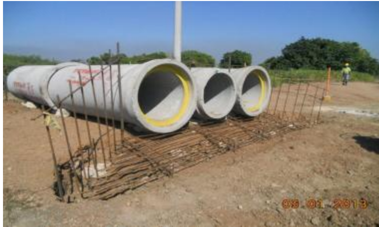
Construcción alcantarillas
