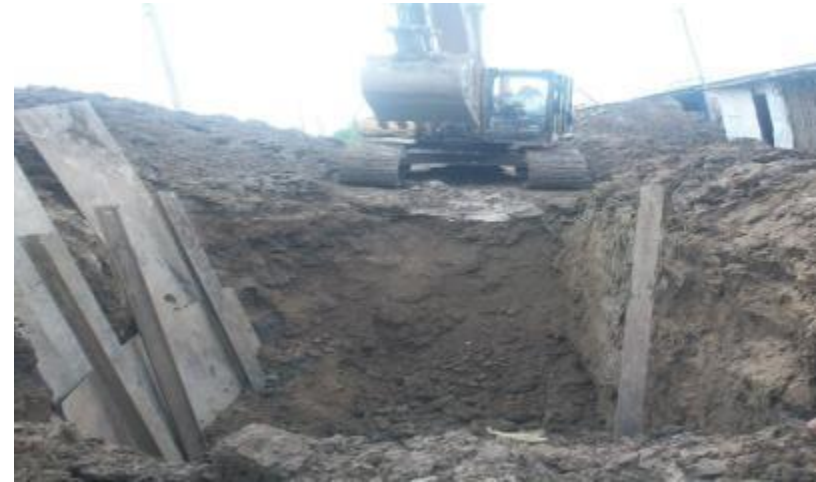
Instalación redes de alcantarillado (con entibado)
