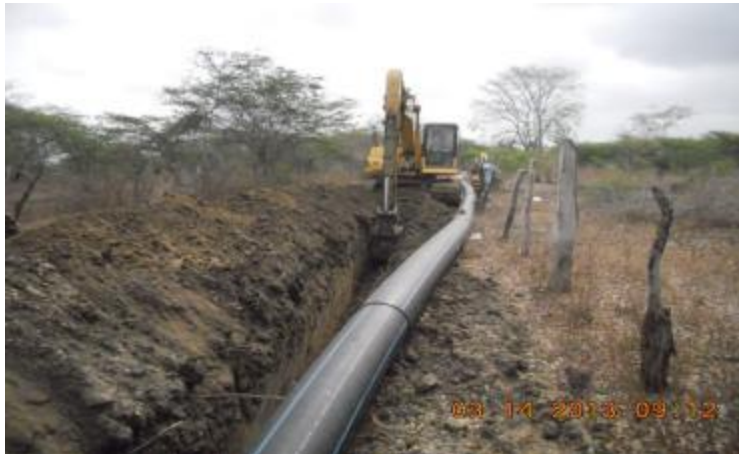
Instalación tubería de aducción
