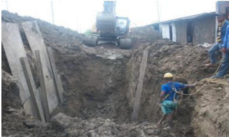
Instalación redes de alcantarillado (con entibado)
