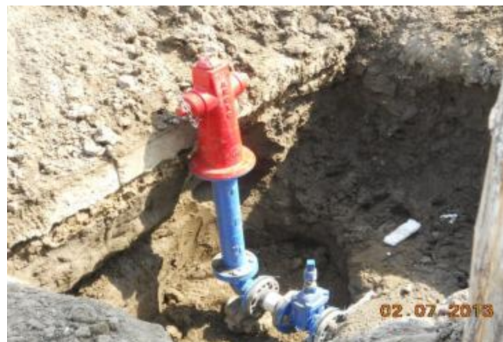
Instalación de hidrantes
