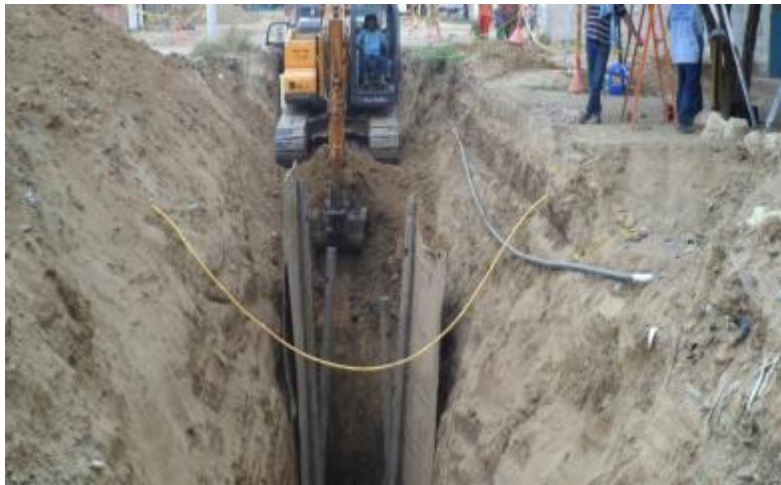
Instalación redes de alcantarillado (con entibado)
