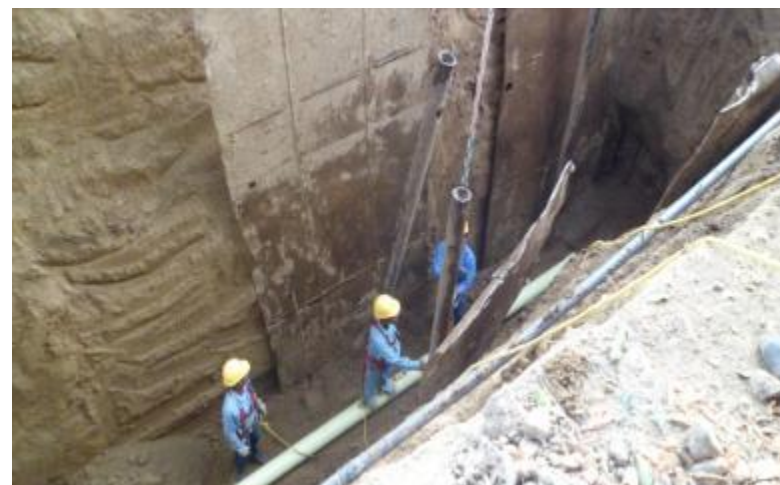
Instalación redes de alcantarillado (con entibado)
