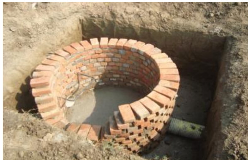
Construcción pozos de inspección
