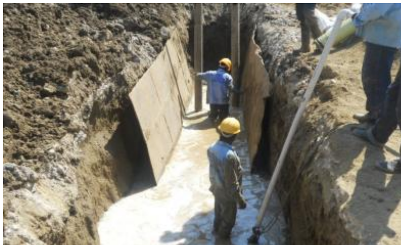
Instalación redes de alcantarillado (con entibado)
