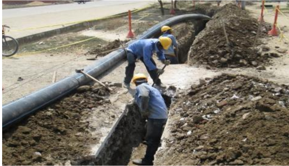
Instalación de Tubería de aducción
