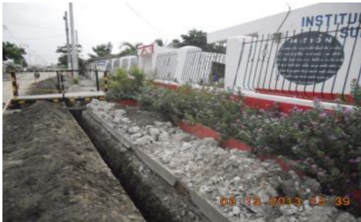
Instalación redes de acueducto.
