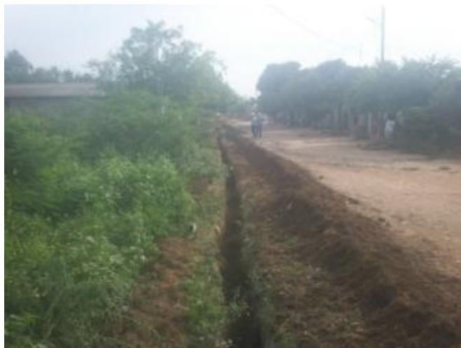
Instalación tubería de aducción
