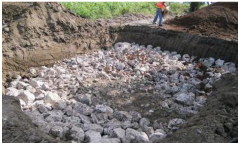
Conformación terraplén
