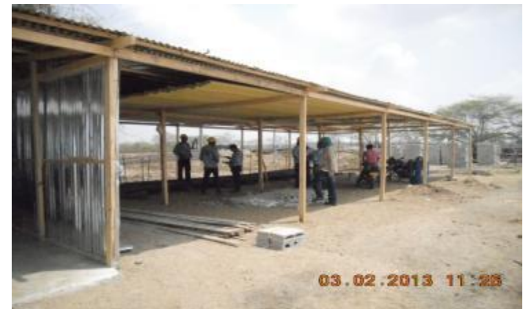
Obras preliminares PTAP.
