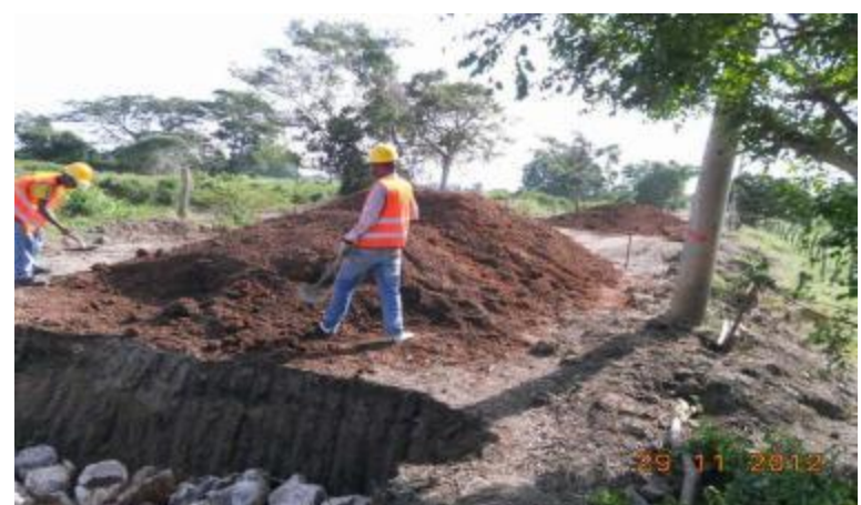
Conformación terraplén
